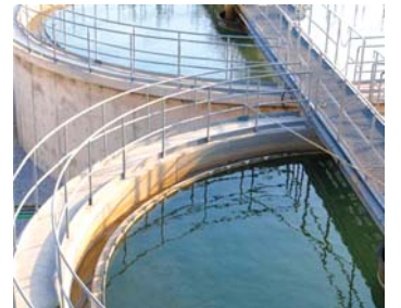
Su / Atık su
